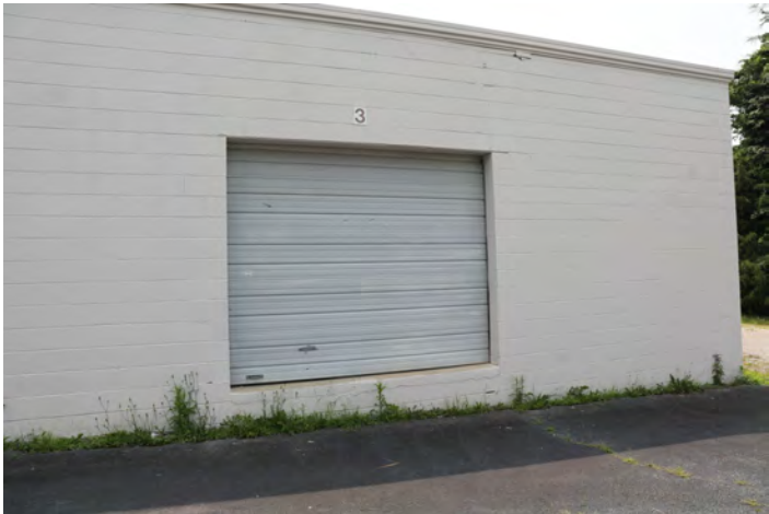
Warehouse Dock Door
